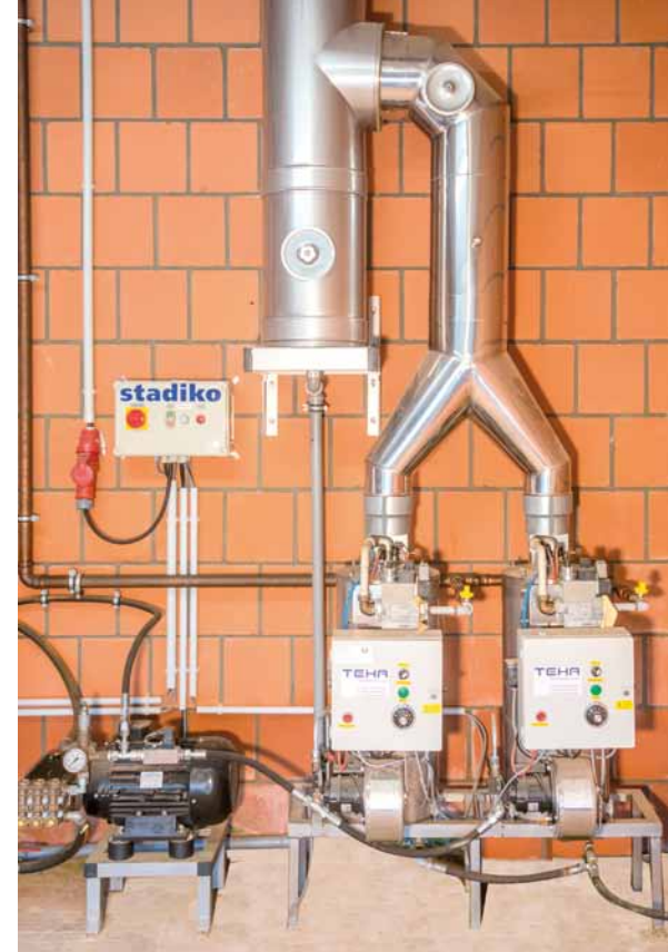
Fixen telepített HD 7,5/30-130 berendezés dupla fűtőkamrával
