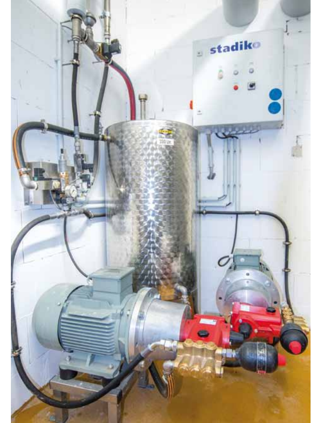
2-fokozatú berendezés külső melegvíz-ellátással
